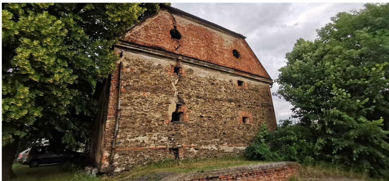
Současný stav sýpky v Holasovicích
