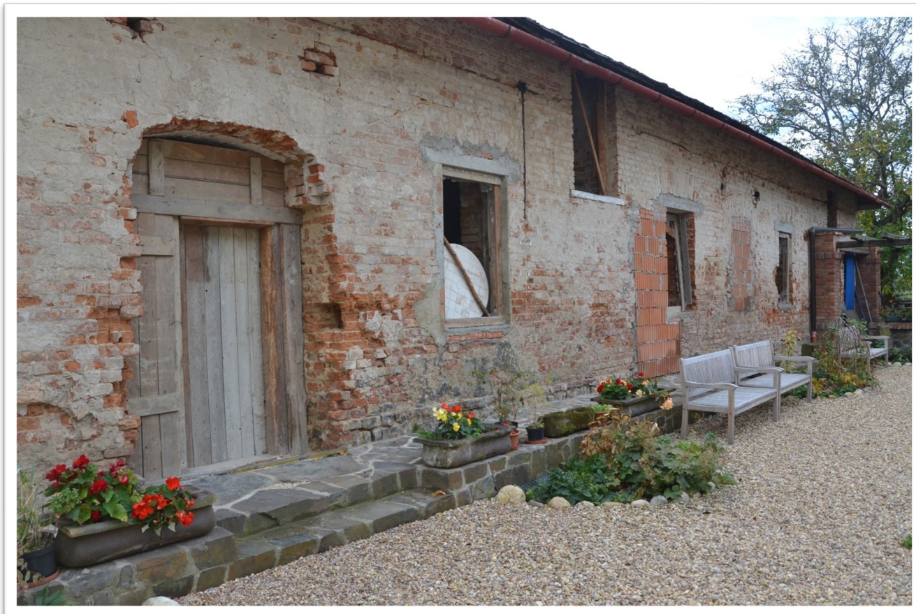
Budova plánovaného hydropavilonu čekající na rekonstrukci.
